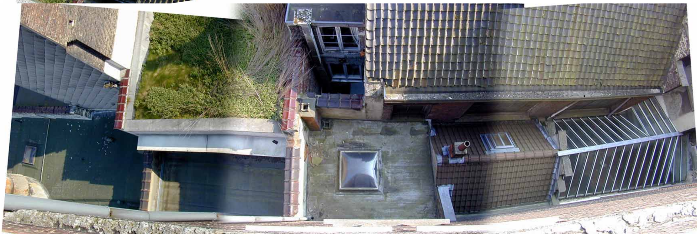
ÎLOT 3, INTERIEUR D' ÎLOT BLOK 3, BINNENGEBIED
