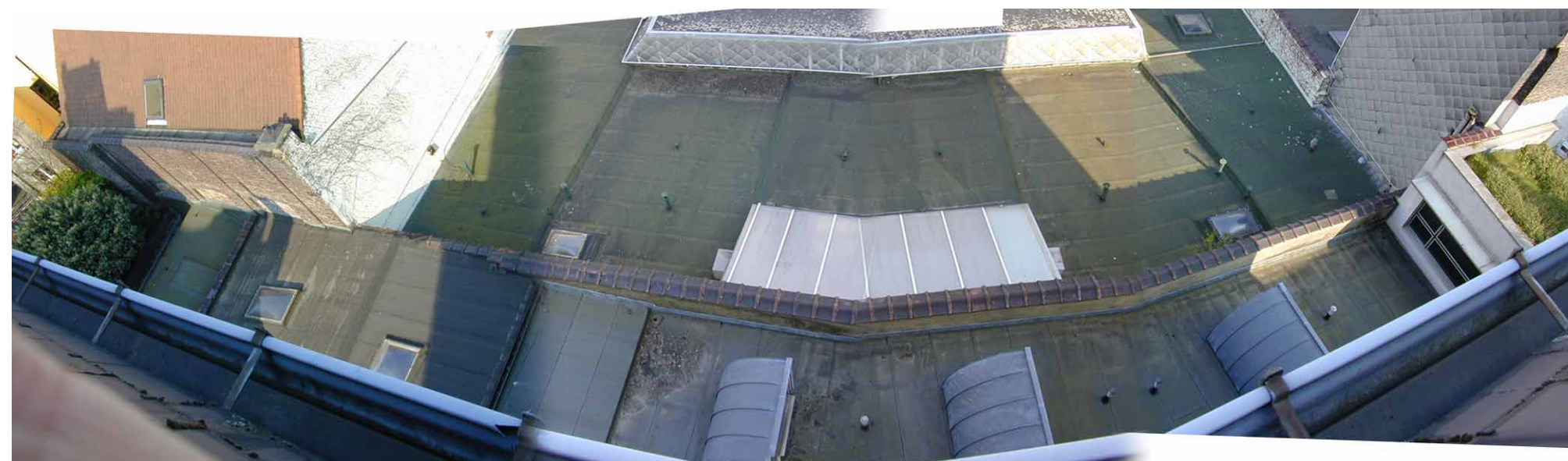
ÎLOT 3, INTERIEUR D' ÎLOT BLOK 3, BINNENGEBIED
