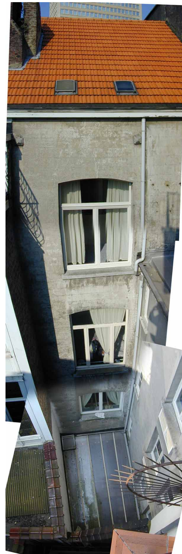
ÎLOT 3, INTERIEUR D' ÎLOT BLOK 3, BINNENGEBIED
